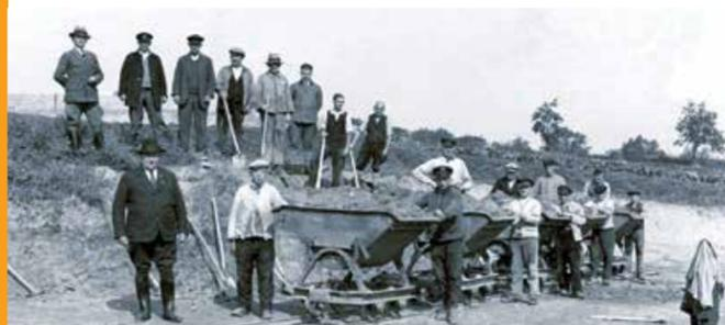
Für die Verlegung der Drainagen wurde zunächst die obere Schicht des Geländes abgetragen. Danach wurde das Erdreich mit leichter Neigung wieder aufgebracht. So konnte das Abwasser dem angelegten Gefälle folgen. Abschließend wurden Wälle, Gräben und Schieber angelegt.
